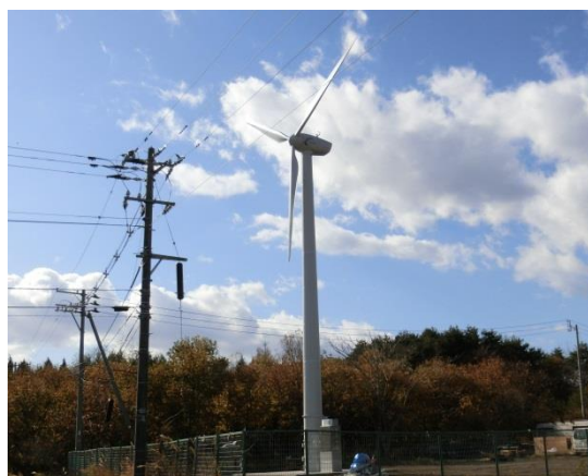
写真:建設された第1号機
